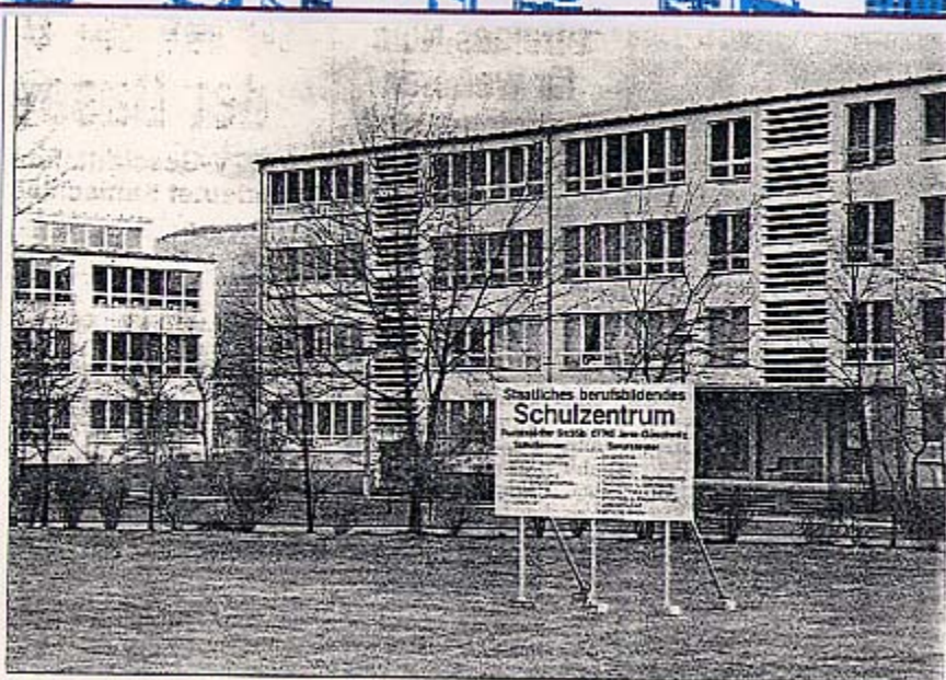
Die Haupteingänge in die drei Schulgebäude des Berufsbildenden Zentrums in Göschwitz werden auf diese Seite verlegt werden. Auch soll auf dieser Seite eine Glasfassade vorgesetzt werden. Doch die ersten Maßnahmen erfolgen an der ehemaligen Lehrproduktionshalle. (Foto: OTZ/Ryoka)
