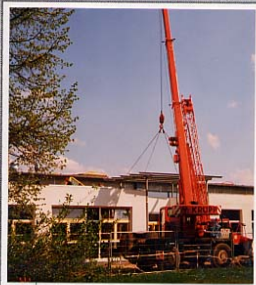
30.4.98 - Arbeiten am Vordach
