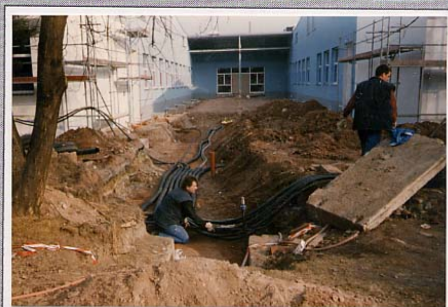
19.2.98 - Viele Kabel müssen verlegt werden...
