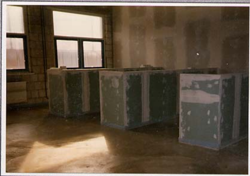
19.2.98 - Ein Sanitärraum ist im Entstehen...
