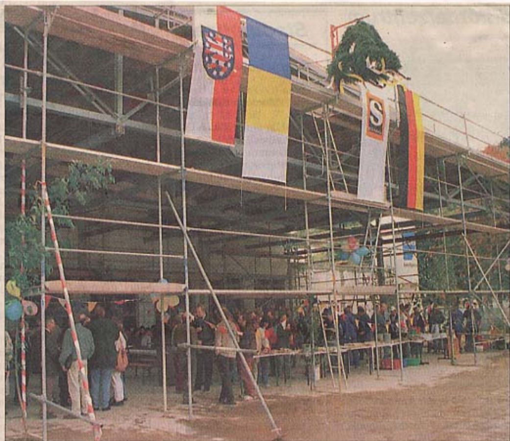
Zum Richtfest geschmückt präsentierte sich gestern der Rohbau des neuen Berufsbildungszentrums in Jena-Göschwitz. (Foto: OTZ/Rybka)
