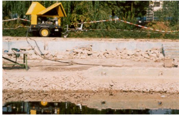
Die Arbeiten beginnen
